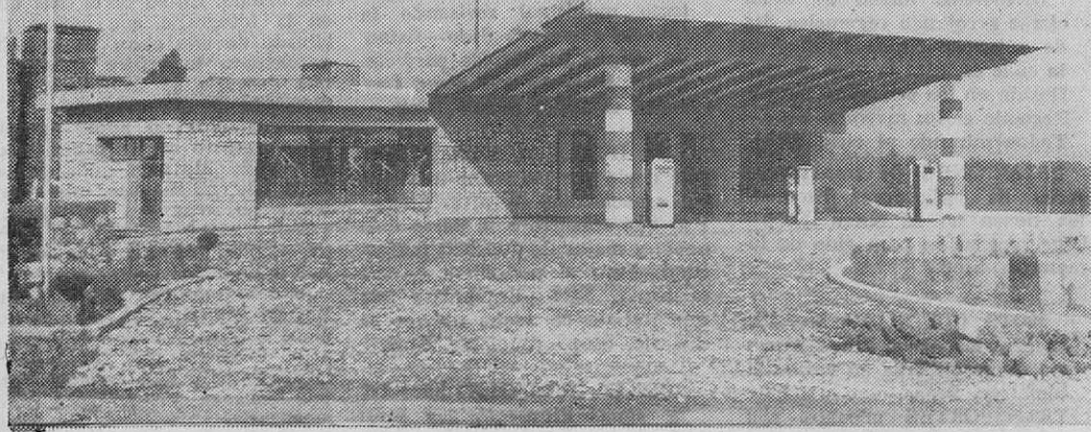
ORENSE.--A nueve kilómetros de la capital, por la carretera de Santiago y Lugo, acaba de ser inaugurada la Estación de Servicio San Cristóbal, en cuya elegante y atrevida visera se emplearon VIGUETAS CASTELO, de Pretensados del Louro, S. L. (Foto Villar.)
