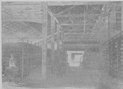
Los grandes secaderos que reciben, por medio de una distribución admirable, el calor sobrante de los hornos. — (Foto Ksado.)
